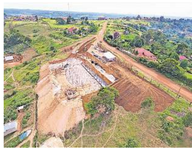
Eine Drohnen-Aufnahme gewährt diesen Blick auf die Baustelle.
