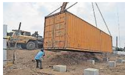
Der Container wird abgesetzt. Er bekommt erstmal ein Dach.
