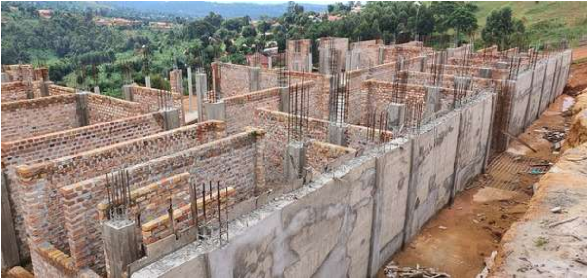
Baustelle der neuen Musikschule
