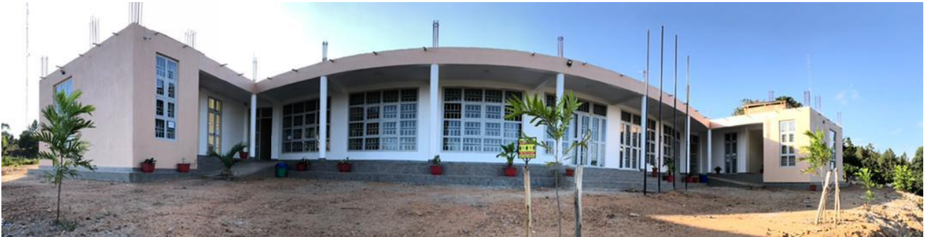
Fertig gestelltes IMLS-Untergeschoss
