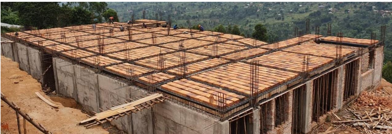
Ein Meilenstein beim Bau der IMLS: Die Decke des ersten Stockwerks
