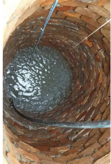
Der eigene Brunnen sichert die Wasserversorgung der IMLS
