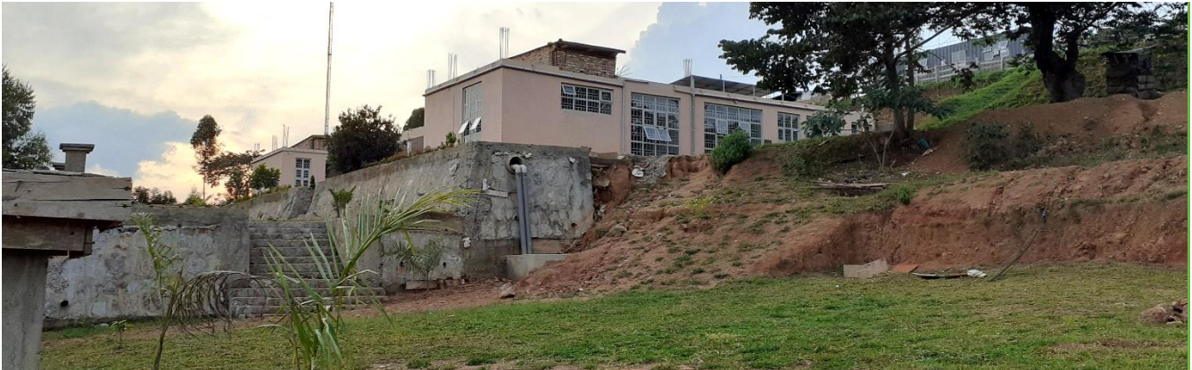
Begrünung und Baumpflanzung IMLS-Außengelände mit Hangstützmauer im Hintergrund
