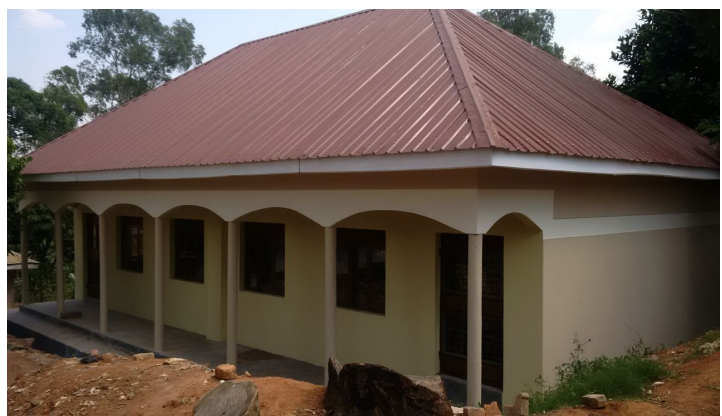
Der fertiggestellte Chorsaal in Masaka/Uganda
