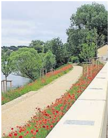
Im Sommer blühten entlang der neuen Flutmauer in Reinhausen etliche Mohnpflanzen. Foto: mds
