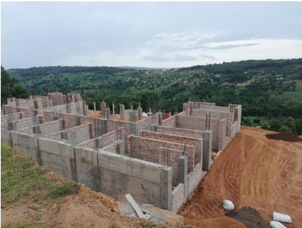
Die neue Musikschule ist im Bau.
